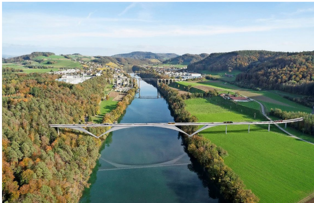
Rahmenbrücke aus Stahl und Beton: Calatravas Lösung für die Rheinquerung bei Eglisau. Visualisierung: PD
