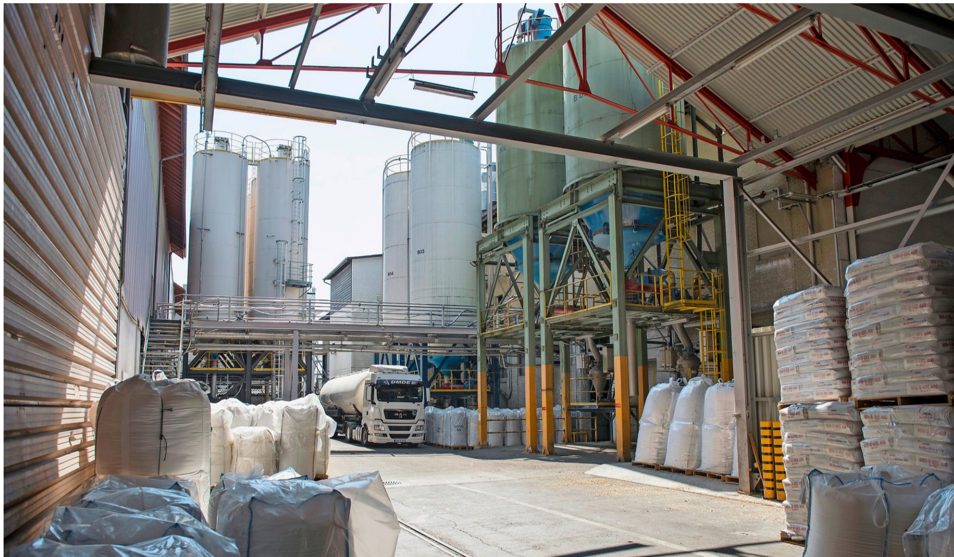
Die Gebäude auf dem Areal der ehemaligen Chemischen Fabrik eignen sich unter anderem als Lagerhallen. Archivfoto: Michael Trost
