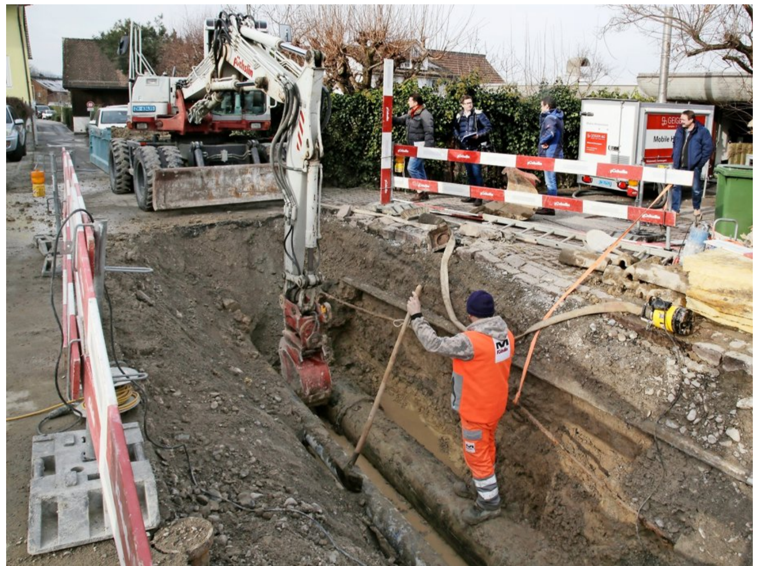
Zwei Arbeiter waren am Mittwoch im Einsatz. Sie rissen ein Stück der Alten Landstrasse auf, um den Schaden begutachten zu können.
