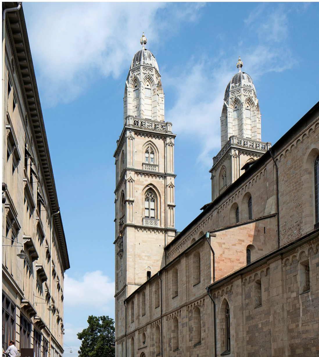
Die Sanierung des Grossmünsters ab 2022 soll die kirchliche wie auch die touristische Nutzung erleichtern – und die Bausubstanz langfristig sichern. Foto: Keystone
